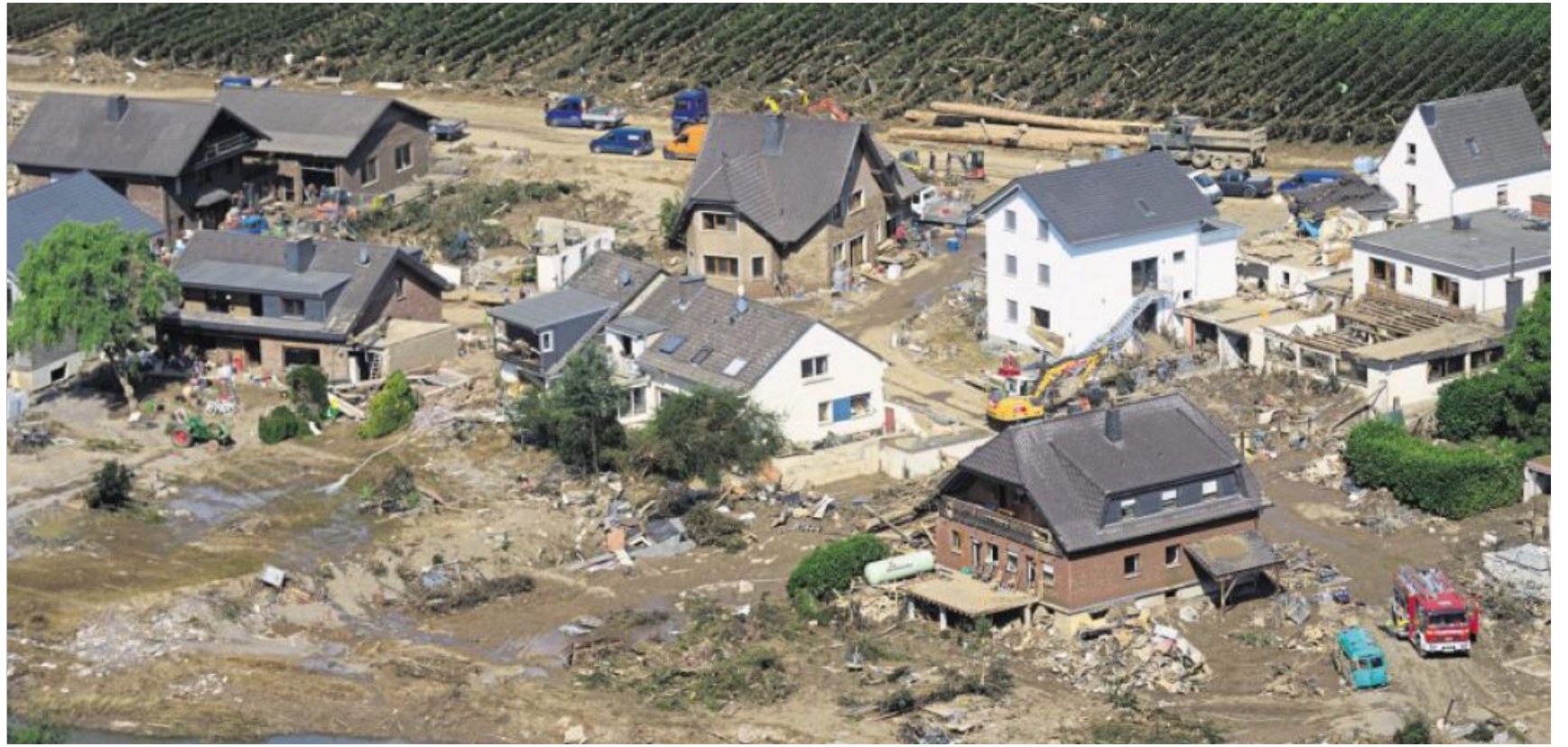
Rettenungskräfte sind nach dem Hochwasser Ende Juli in Marienthal in Rheinland-Pfalz im Einsatz. Die Flut hat auch hier zahlreiche Häuser zerstört. Angesichts des Hochwassers gab es Fragen, ob dieses eine Folge des Klimawandels ist. Archivbild: Thomas Frey/dpa
